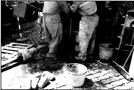
F8 - Prescavo manuale
