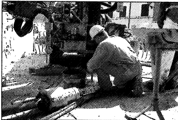
F1 Prescavo manuale
